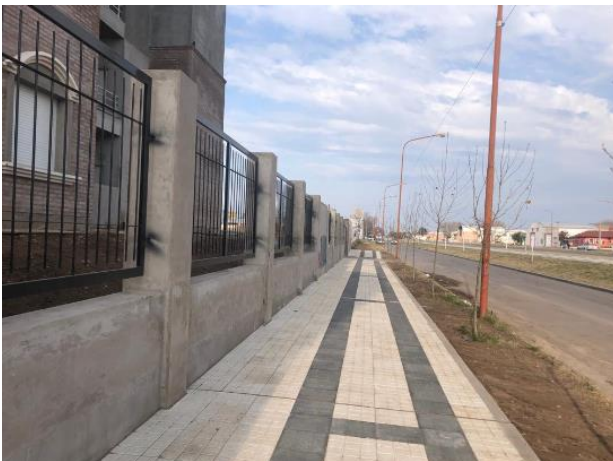
Vereda terminada sobre Av. Circunvalación
