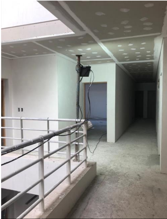
Colocación placas de roca de yeso en cielorraso
